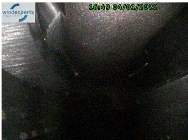
IMS Welle, Lager Generatorseite zweireihig, nur sehr bedingt einsehbar, unauffällig.
