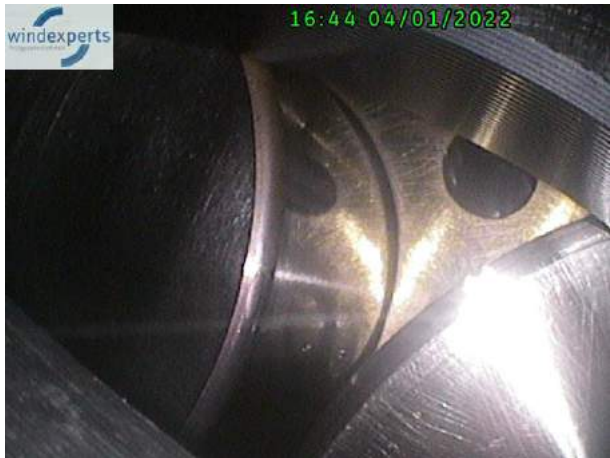
IMS Welle, Lager Rotorseite bedingt einsehbar, unauffällig.
