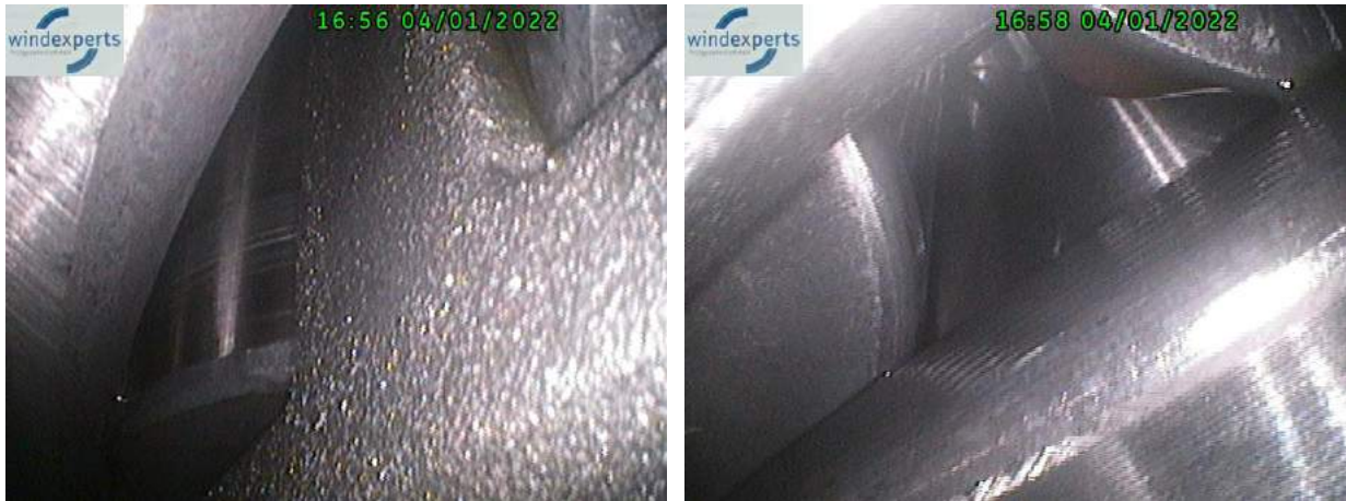
LSS Welle, Lager Rotorseite bedingt einsehbar, unauffällig
